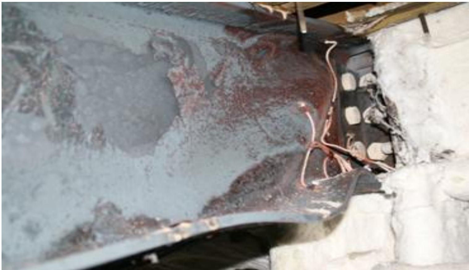
Neapsaugotos šalutinės sijos, prijungtos prie kolonos, vietinė kluptis
