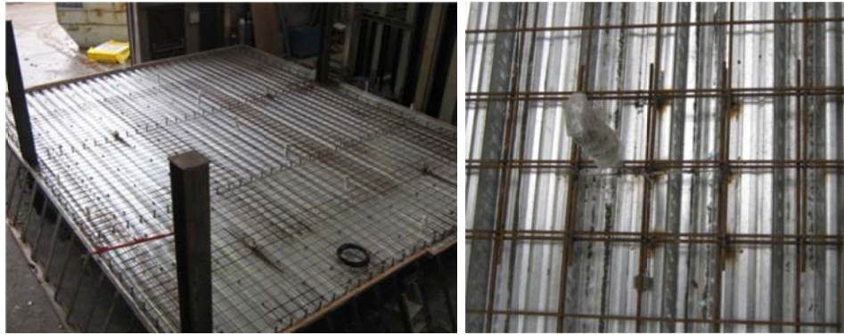
Figure 7.43 Recouvrement du grillage d'armatures métalliques dans la dalle mixte
