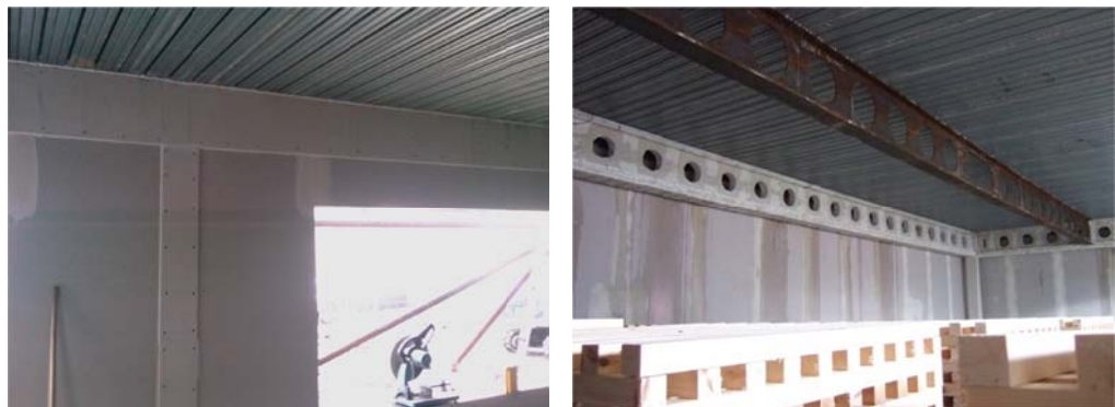
Figure 7.47 Protection en fibres et en plaques de plâtre utilisé à l'intérieur du compartiment
