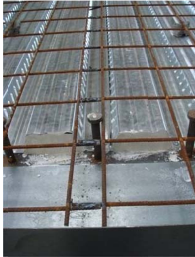
(a) Assemblage des armatures soudées avant le coulage du béton (b) Etat de l'assemblage d'armatures à la position de la fissure après refroidissement
