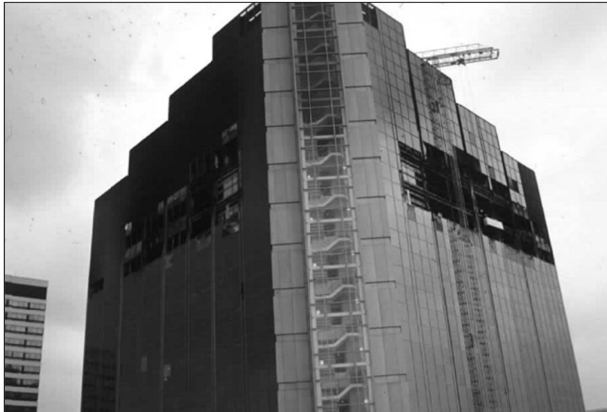
Figure 4.3 Churchill Plaza, Basingstoke après l'incendie
