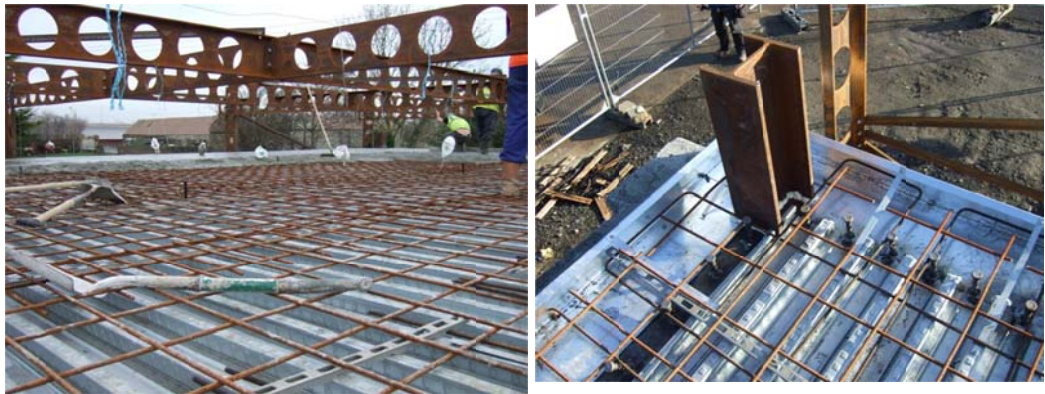
Figure 7.48 Grillage d'armatures et coffrage métallique avant le coulage du béton
