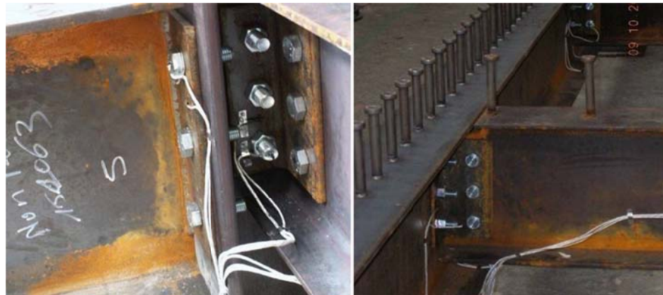
(a) Assemblages poutre-colonne avec des plats d'extrémité souples et à double cornière d'âme (b) Assemblages poutre-poutre à double cornière d'âme
