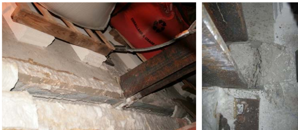
Figure 7.42 Fissuration du béton autour des colonnes centrales
