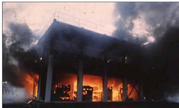
Figure 4.4 Bâtiment test de BHP et essai au feu
