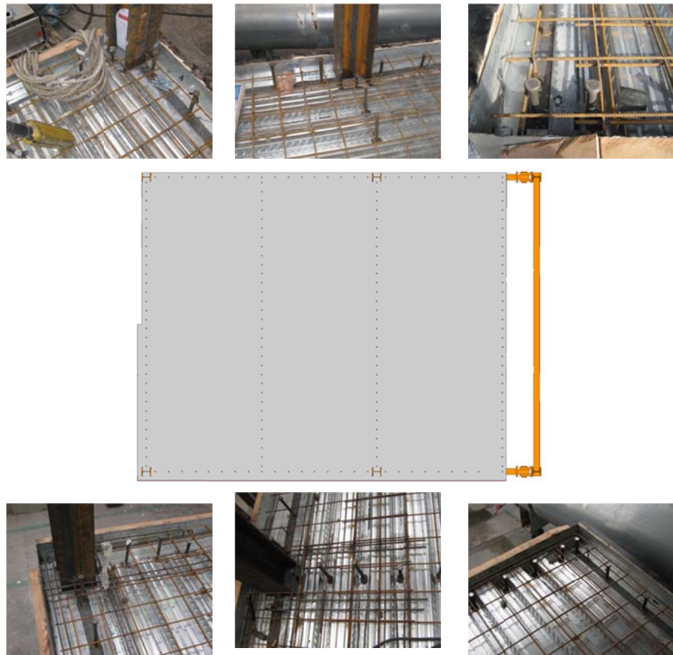
Figure 7.23 Différentes configurations de assemblages mixtes acier béton
