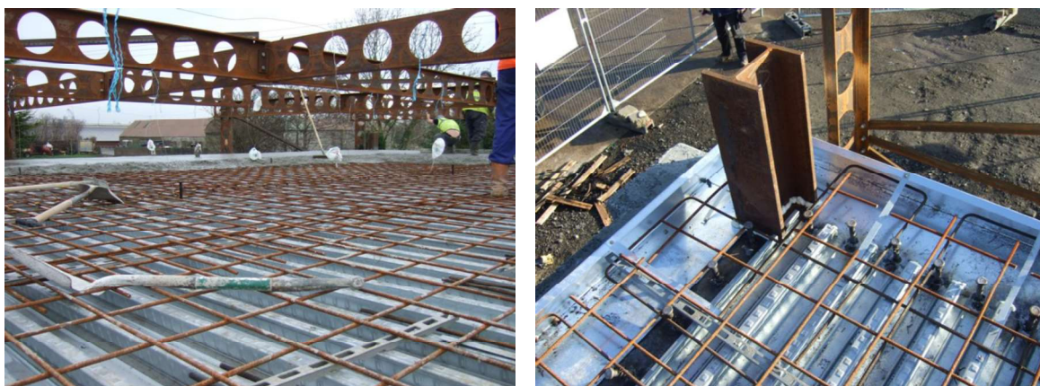
Figuur 7.48 : Wapeningsnet en staalplaat voor betonstorten
