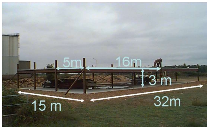
Figuur 3.1 Open parkeergarages vóór de brandproeven
