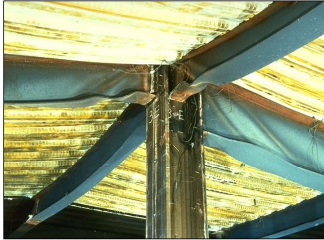
Figuur 2.20 Kolomkop met geplooide liggers
