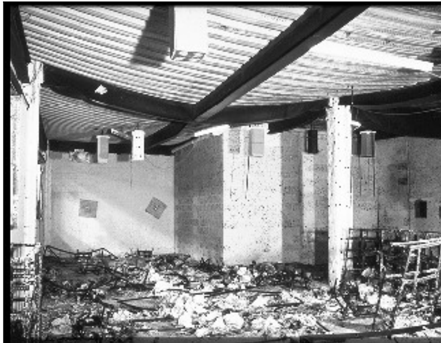
Figuur 2.19 Het compartiment na de brand
