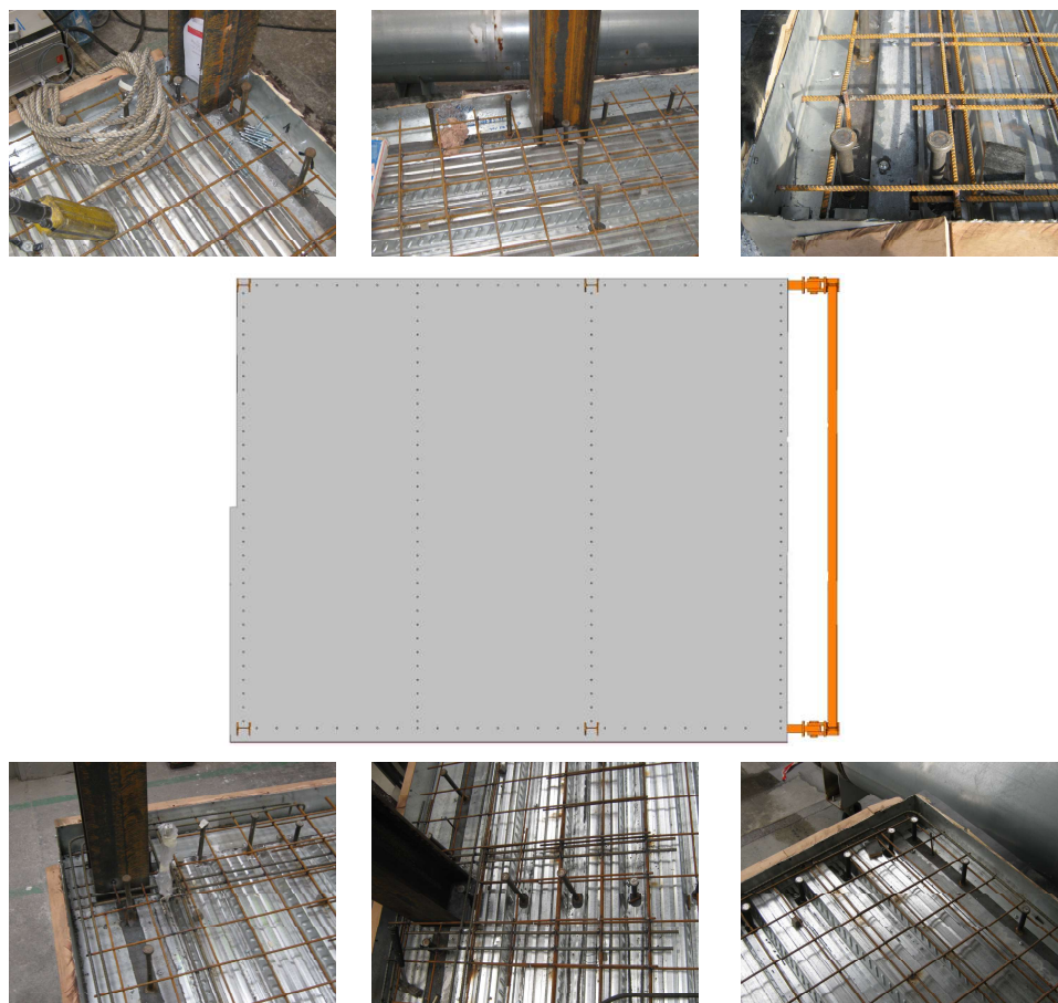
Figuur 7.23 Verskillende samenwerkende staal-beton verbinding-configuratiess
