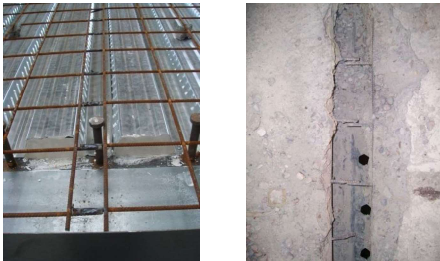
(a) Gelaste verbinding van de wapening vóór het storten van het beton (b) Status van de wapeningverbinding bij de plaats van de scheur na afkoeling
