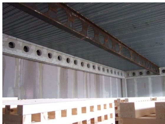
Σχήμα 7.47 : Ινοπροστασία και προστασία γυψοσανίδας εντός του διαμερίσματος
