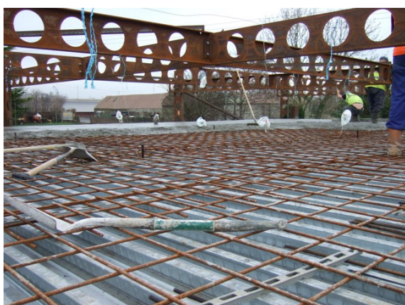
Σχήμα 7.48 : Το πλέγμα ενίσχυσης και το μεταλλικό υπόστρωμα πριν από τη σκυροδέτηση
