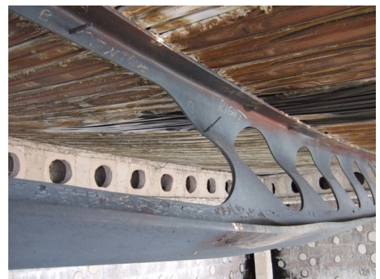
Σχήμα 7.53 : Μετατόπιση της πλάκας και της μη μονωμένης δοκού μετά από την πυρκαγιά.
