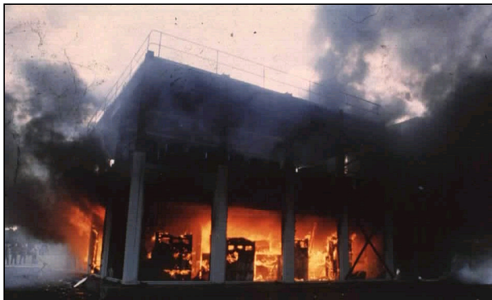
Σχήμα 4.4 Το κτίριο του πειράματος και το πείραμα πυρκαγιάς της BHP
