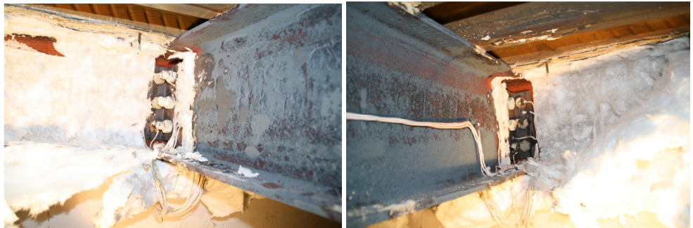
Σχήμα 7.40 Κανένας τοπικός λυγισμός των μη μονωμένων δευτερευουσών δοκών που ήταν συνδεδεμένες στις κύριες δοκούς
