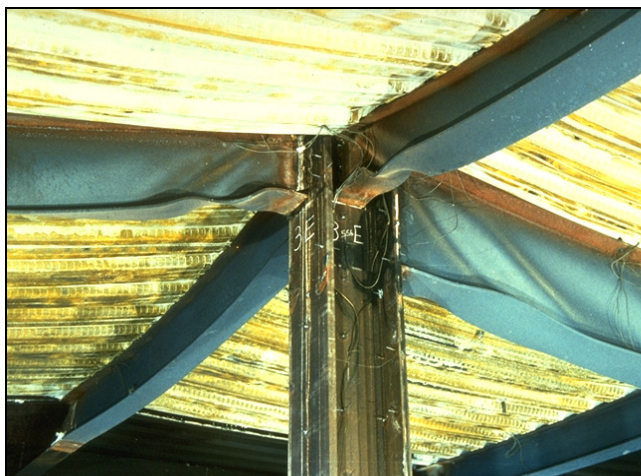
Σχήμα 2.20 Κεφαλή στύλου που εμφανίζει λυγισμένες δοκούς
