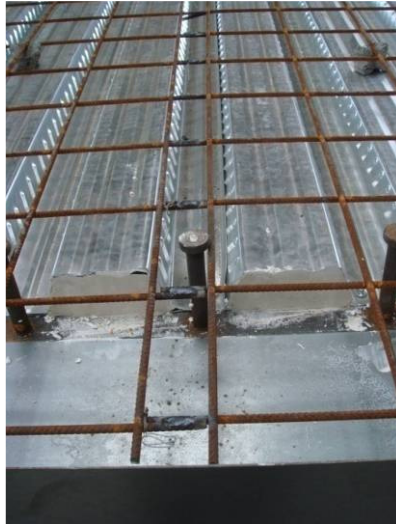
(a) Συγκολλημένη σύνδεση οπλισμού πριν από τη (b) Η σύνδεση οπλισμού στην τοποθεσία της σκυροδέτηση ρωγμής μετά από την ψύξη
