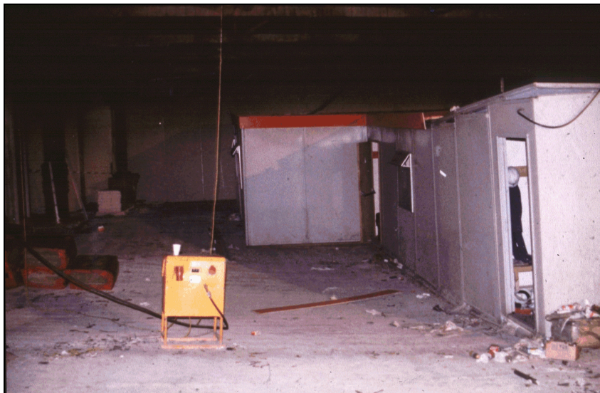
Σχήμα 4.2 Όψη της παραμορφωμένης πλάκας πάνω από την πυρκαγιά (μέγιστη παραμόρφωση: περίπου 600 mm)
