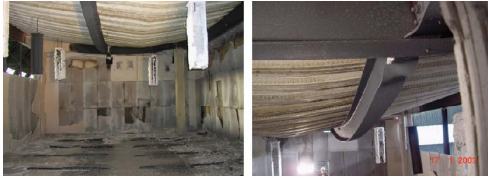
Σχήμα 2.25 Όψη της πλάκας μετά από το πείραμα
