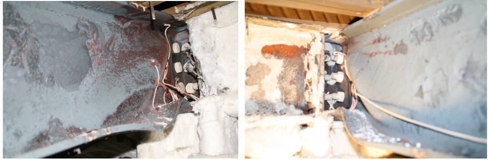
Σχήμα 7.39 Τοπικός λυγισμός των μη μονωμένων δευτερευουσών δοκών που ήταν συνδεδεμένες σε στύλο
