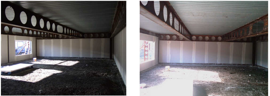
Σχήμα 7.44 : Διαμέρισμα του πειράματος με μη μονωμένες κυψελωτές δοκούς μεγάλου ανοίγματος
