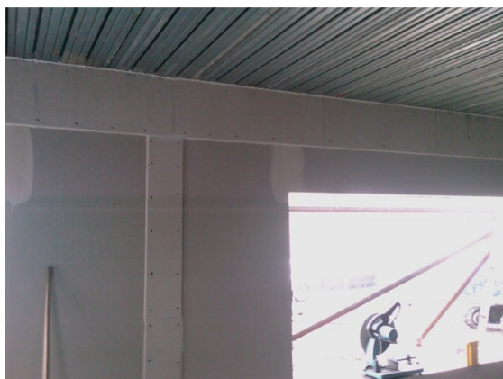
Σχήμα 7.47 : Ινοπροστασία και προστασία γυψοσανίδας εντός του διαμερίσματος
