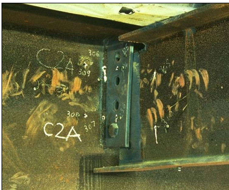
Σχήμα 2.8 Σύνδεση πτερυγωτών ελασμάτων (ελάσματα παράλληλα στον κορμό) μετά από το πείραμα
