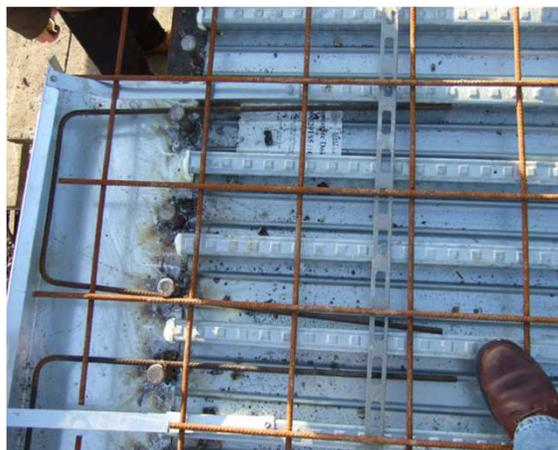
Treillis soudé A393, diamètre 10 mm
