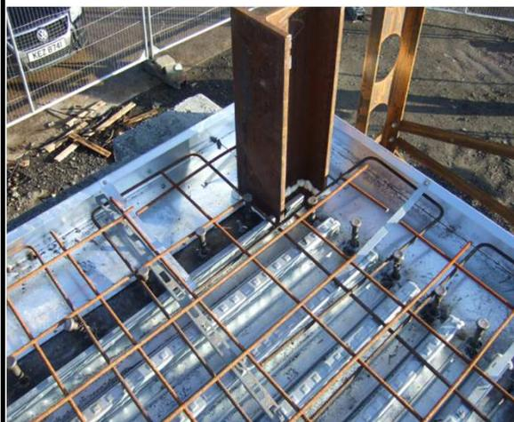
Connexion complète entre la dalle et les poutres
