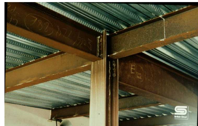
Unión viga con columna
