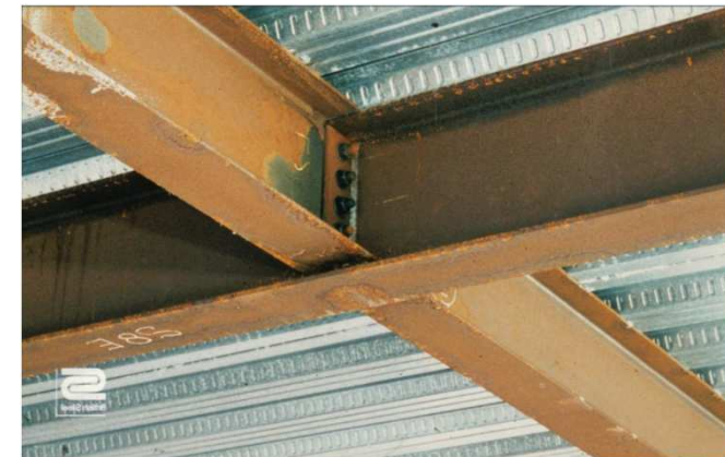
Unión viga con viga
